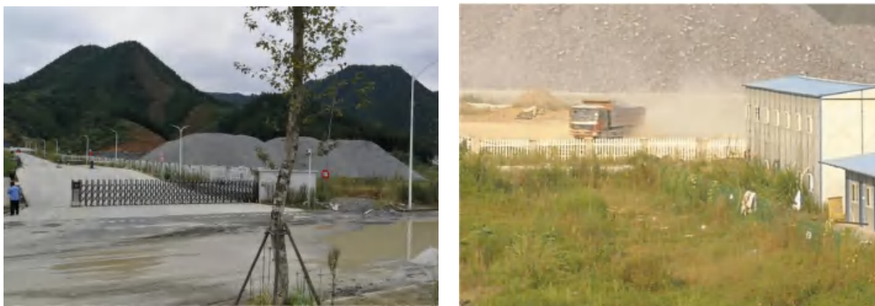
图 7.4.1 项目东侧存在料石堆场（左图）及场地平整施工现象（右图）
