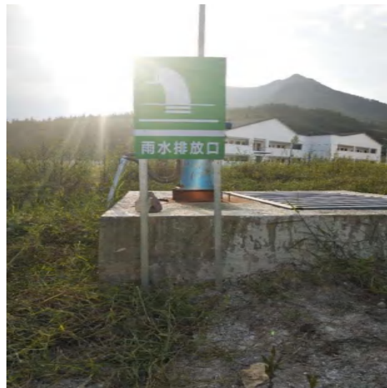
生活区雨排口
